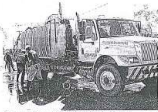
El equipo Victor trabaja en reducida capacidad para limpiar la red de Revuosa.
